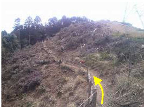
尾根筋は鉄塔建設中で迂回路を歩く。
