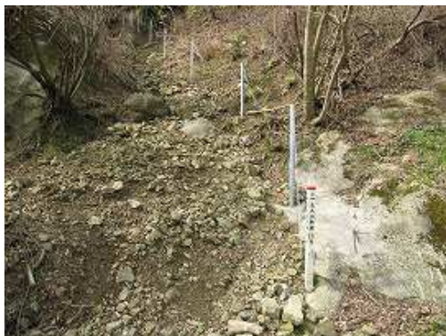
鉄塔130への取付き点。駐車場の先のフジ棚の前の斜面で、クサリ付の鉄柵を頼りに上り右へ折れる。
