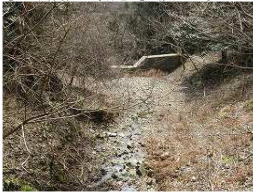
上流の砂防ダムから下流の砂防ダムを望む。
