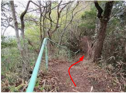
北西側に 手摺パイプ が設置されている。。
