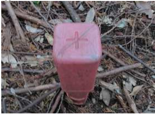
赤プラ杭を見る。
