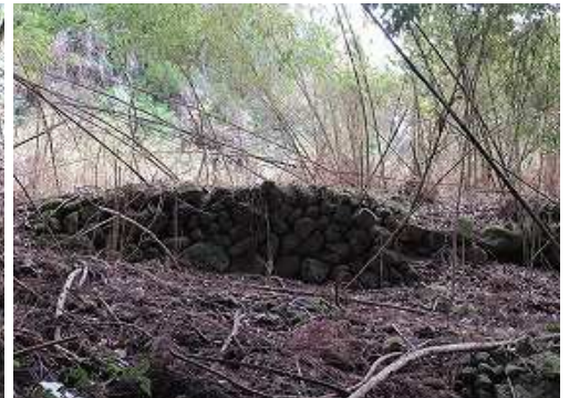
東側斜面には石積みが残っている。
