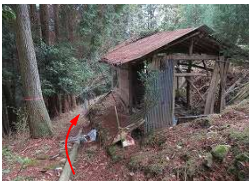
朽ちた作業小屋Bを抜ける。
