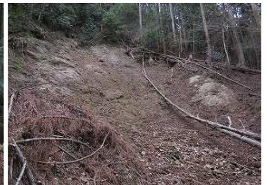
地滑り斜面を見上げる。
