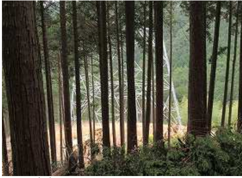
南南西に 鉄塔47号 の基部を垣間見る。
