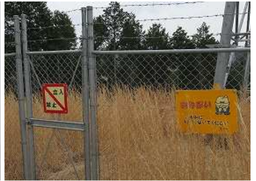
周囲はフェンスで囲まれている。
