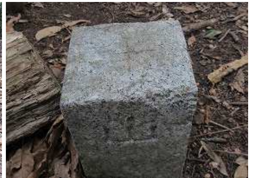
山と彫られた図根杭が設置されている。
