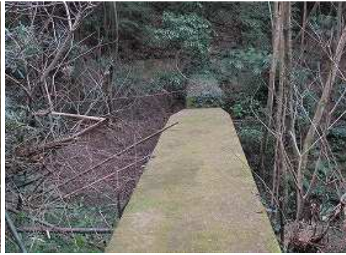
左手に砂防ダムを見送る。
