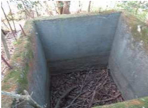
覗くと貯水槽のようであるが、水は溜まっていない。
