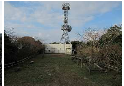
北西の広場1の奥に中継局が立っている。
