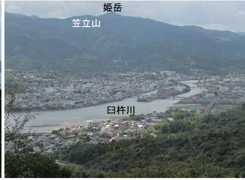
南に臼杵市街を見下ろす。
