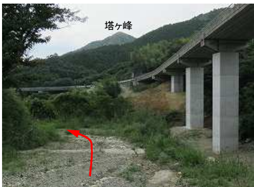
県道28号の高架橋を見上げる。
