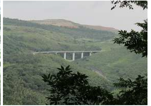
展望B 北西に県道28号の橋梁を見下ろす。
