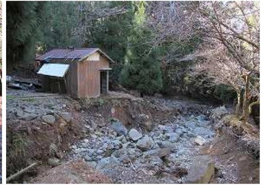
作業小屋前の作業路が流出しており、左の沢へ回り込む。
