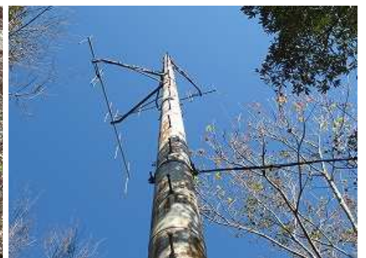
北側に中継所を見上げる。
