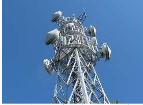
宮崎県防災行政無線速日峰中継所を見上げる。
