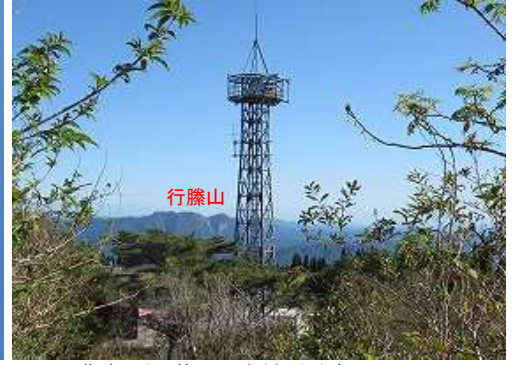
北東にも3基目の中継所が建っている。
