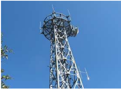
3基目の中継所を見上げる。
