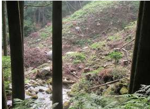
南面里川東の斜面が伐採されている。
