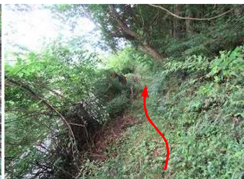
道路擁壁上部を南へ進む。
