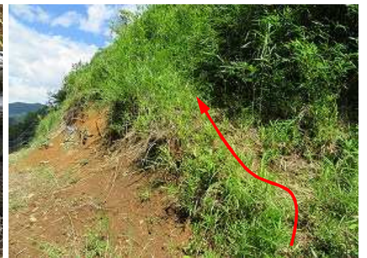
南西側の法肩に取付く。
