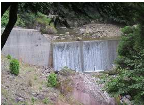
宇土内谷に砂防ダムを見る。
