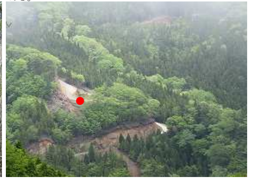
東南東に林道Bを見下ろす。
