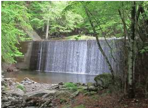
砂防ダムを見送る。
