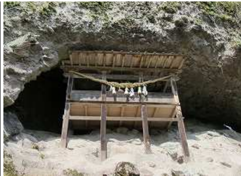
懸造り板葺き三間社流見世棚造りの熊野神社。
