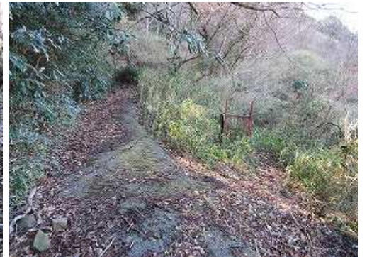
作業路上方の様子。
