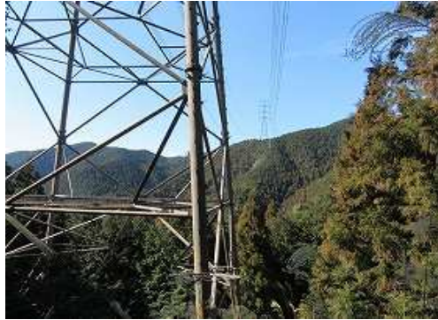
送電線が延びる西北西を望む。
