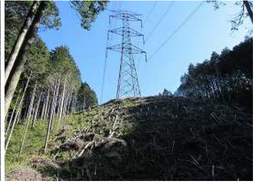
伐採斜面の頂部に鉄塔15号が見える。
