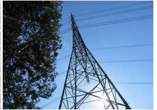
鉄塔15号を見上げる。
