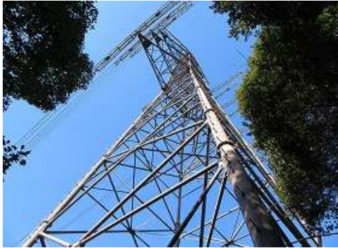
鉄塔14号 を見上げる。
