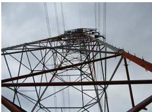
赤白の鉄塔39号を見上げる。
