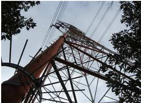
鉄塔40号を見上げる。
