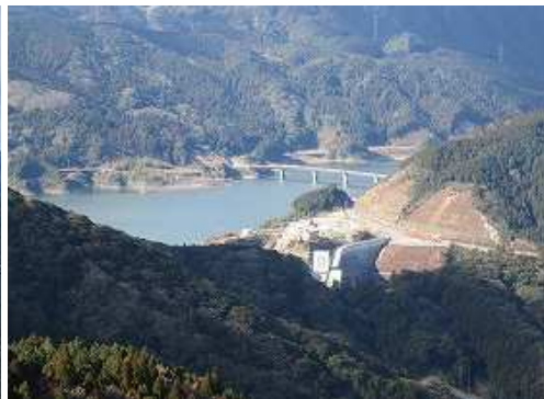
五ヶ山ダムを見下ろす。
