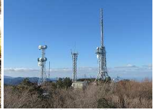
展望塔から北の電波塔。
