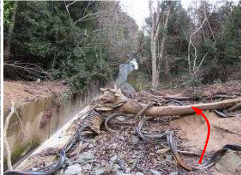
階段 が左斜面の土砂崩れで 被災 しており、越えて行く。
