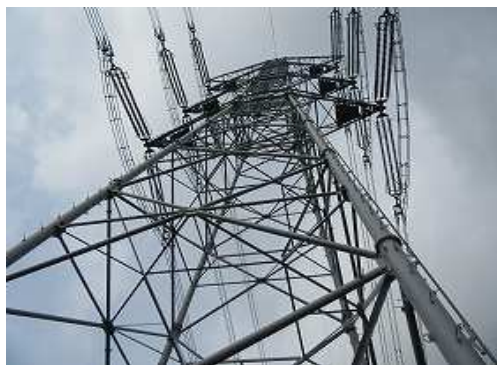
鉄塔62号 を見上げる。
