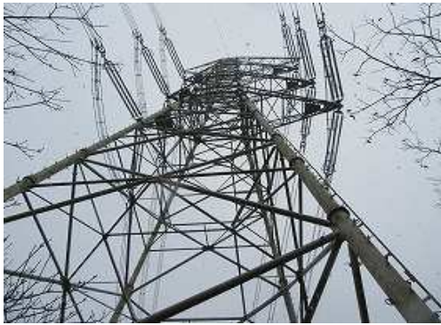
鉄塔64号を見上げる。
