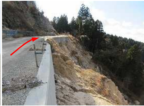
崩落地は復旧工事が済んでいた。
