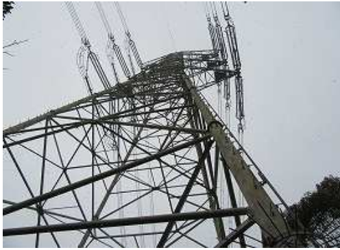
鉄塔63号を見上げる。
