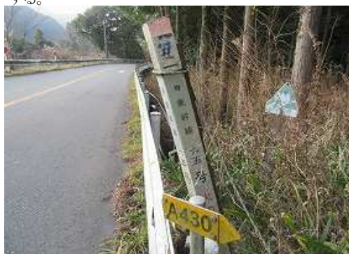
巡視路入口の鉄塔標柱。
