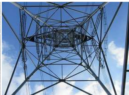
鉄塔68号を見上げる。
