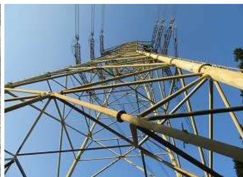
鉄塔65号を見上げる。
