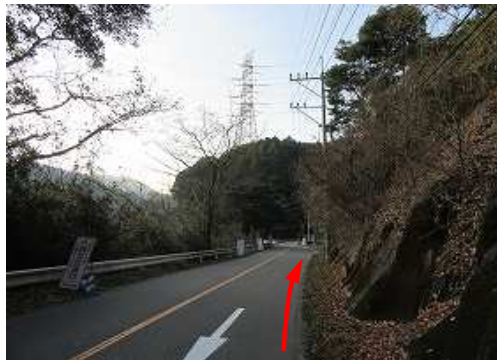
国道385号を南へ向かうと鉄塔65号が見えた。
