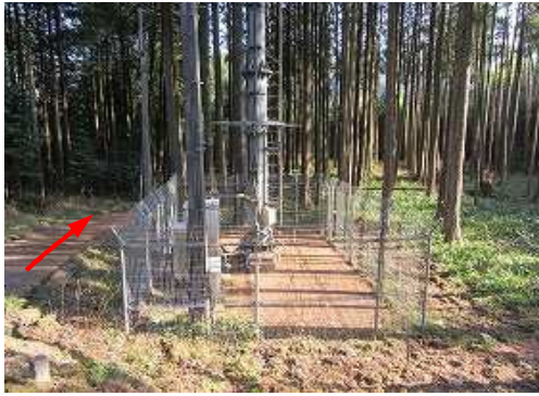
ドコモ五ヶ山基地局を見る。
