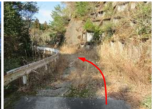
舗装終了となる。
