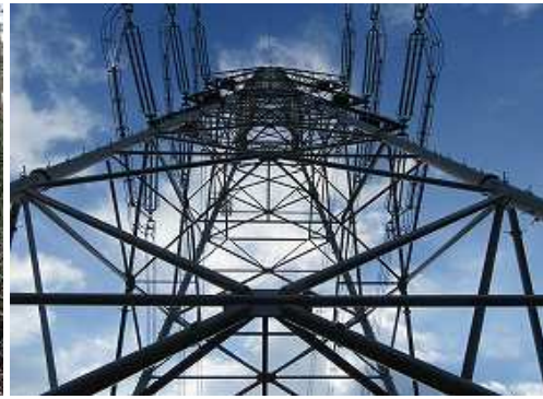
鉄塔67号を見上げる。
