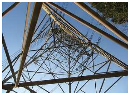
鉄塔66号を見上げる。
