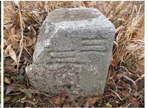
明治30年に造標された三等三角点：上矢岳 (385.66m)を見る。左天端の「等」が欠損している。
