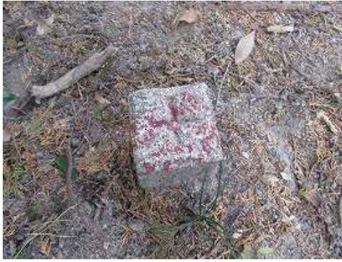
境界杭を見る。
