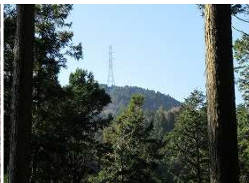
作業路跡から南南西に脊振伊都線の鉄塔26号を見る。
