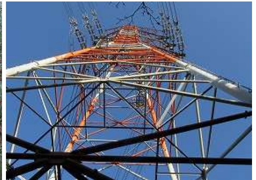
鉄塔27号を見上げる。
