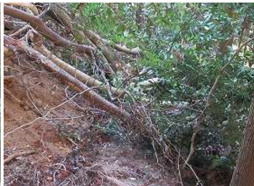
古道前方に土砂崩れが現れた。
