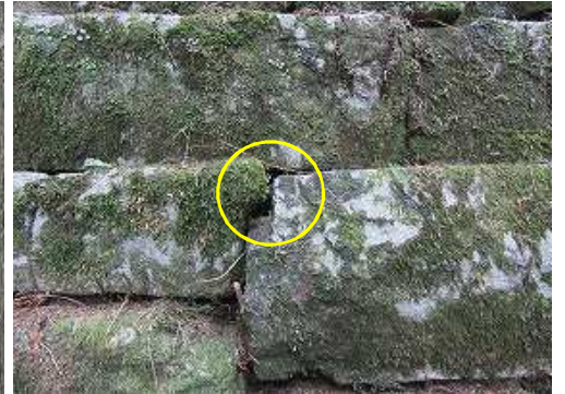
矩形に加工された石材を布積みで施工しており、切り欠き加工や間詰石が見られ施工精度や完成度が高い構造物である。
