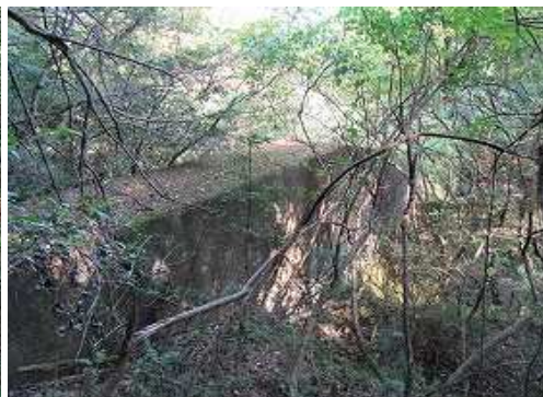
砂防ダムの左岸際を抜ける。
