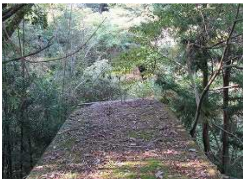
右に砂防ダムを見送る。
