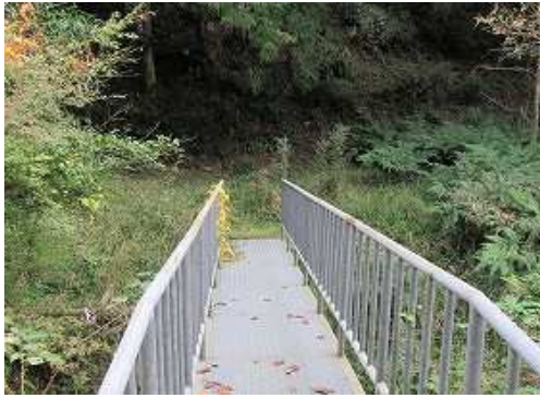
遊歩道入口の橋が右岸へ架かっている。
