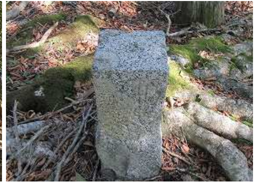
補点杭が設置されている。
