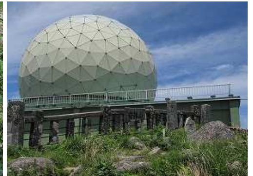
航空自衛隊レーダードーム。
