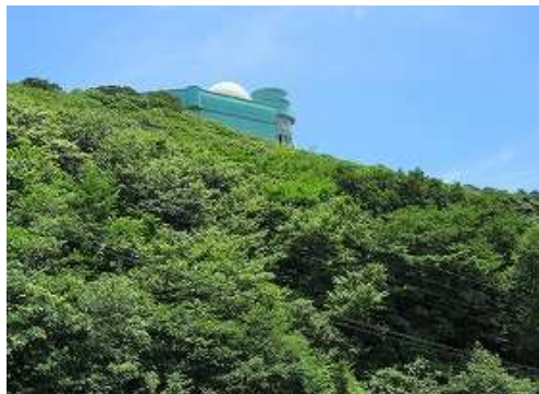
出合った道路からドームを望む。
