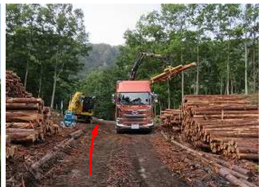
集積場では搬出作業が行われていた。
