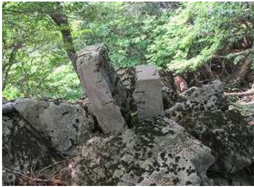
尾根筋に劣化杭を見る。
