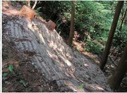
復旧工事が終わった崩落斜面を見下ろす。
