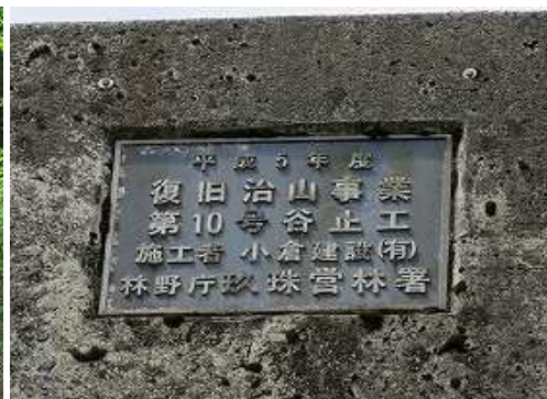
砂防ダム の銘板。
