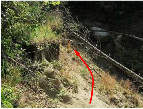
林道崩落が現れ、崩落斜面を抜ける。
