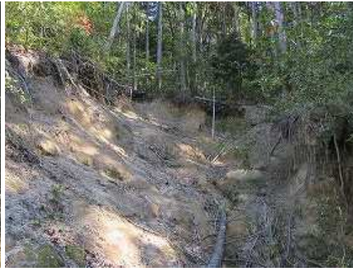
林道崩落を起こした崩落斜面の上部。
