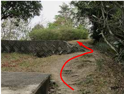
石積ブロックが現れた。
