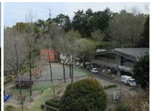
管理事務所を見下ろす。
