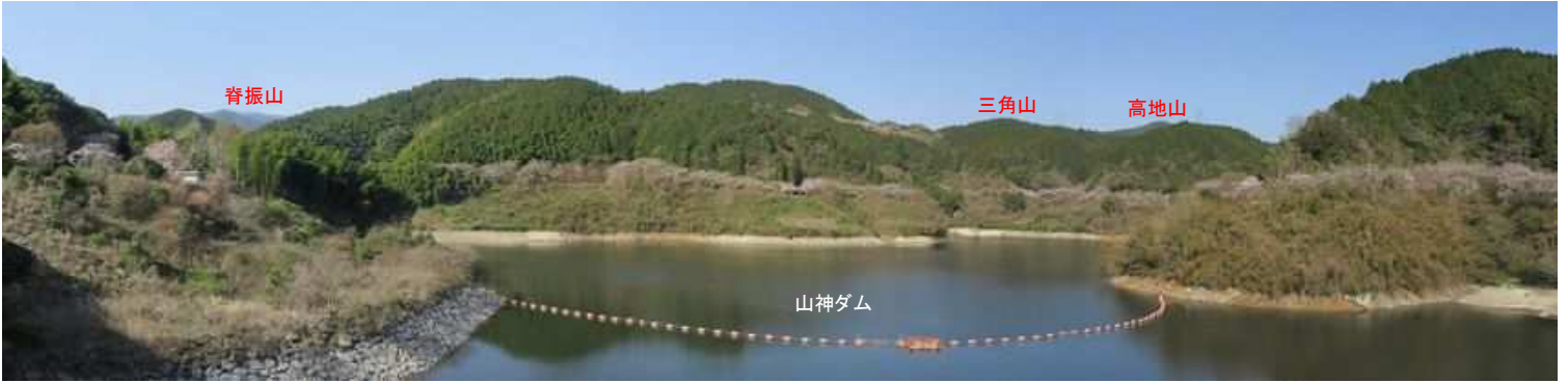
堰堤中央部から西を望む。
