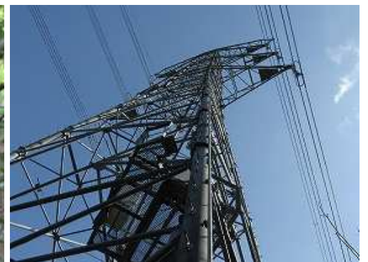
鉄塔32号を見上げる。
