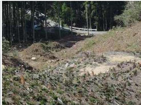
西の県道601号を見下ろす。
