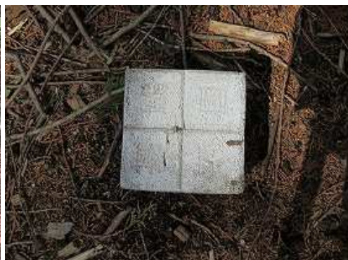
尾根筋に劣化した国調杭を見る。
