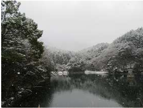
草ヶ谷ダムから南東を見るが奥はガスっている。
