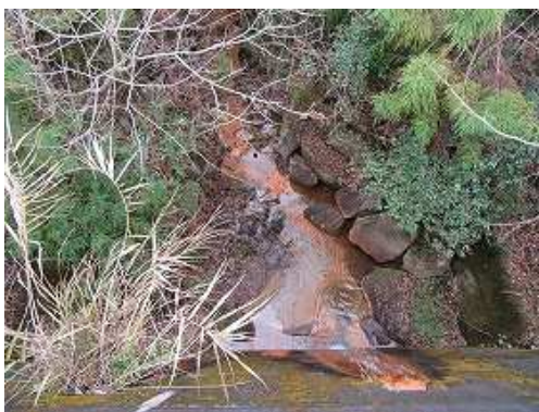
砂防ダムから下を覗く。
