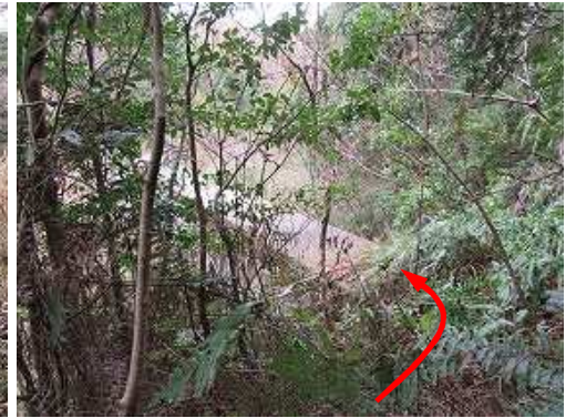
少し北へ移動すると砂防ダム右岸に出合い、そこへ下る。
