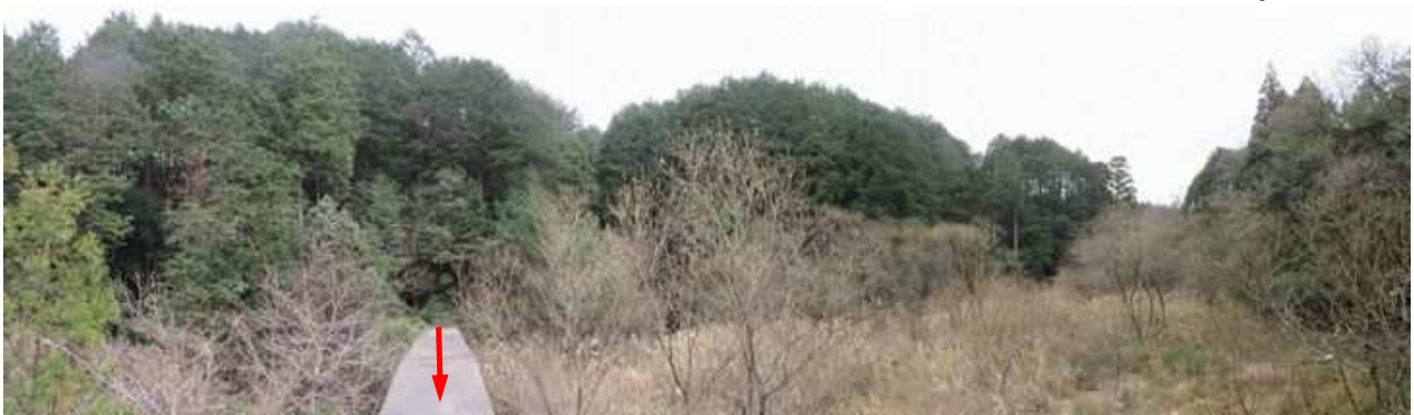
砂防ダムから南を望む。
