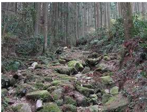
石畳は剥れゴロ帯となっている。
