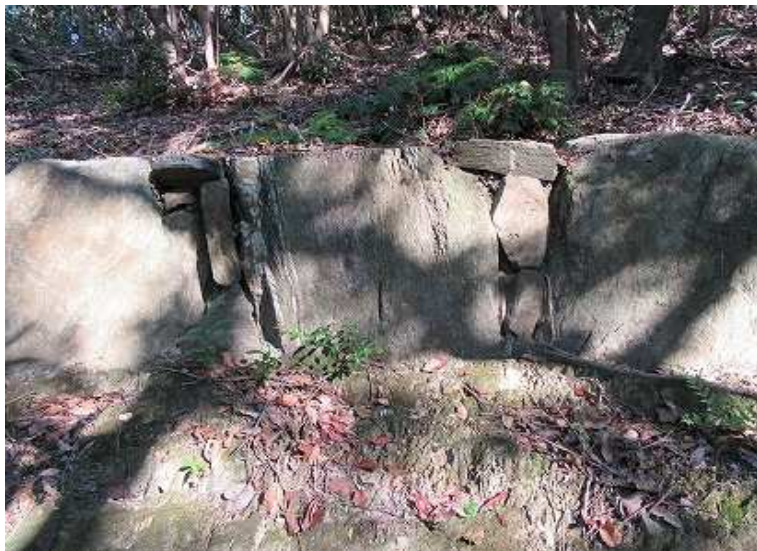
隙間には間詰石として栗石を詰めている
