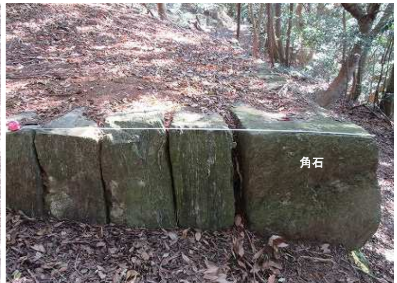
角石の手前は長さ40cm程の切石を3個縦並べとしている
