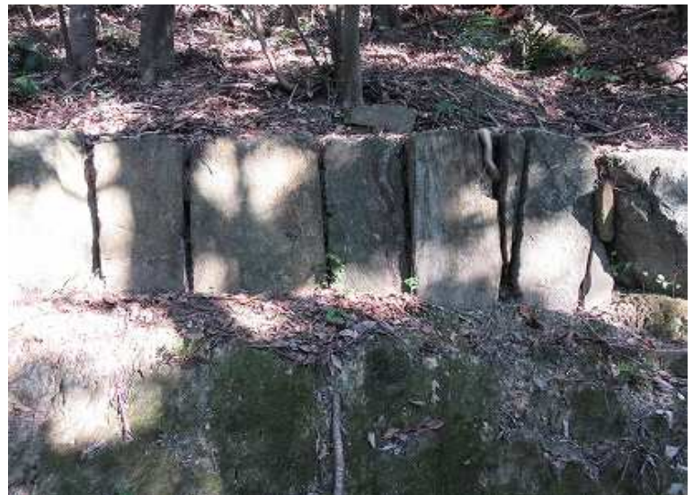
縦長の切石を多用している
