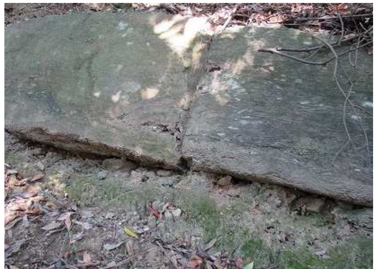
ここでは摺付底面がそろっている。 屑石と土を混合して底面を造っているようだ
