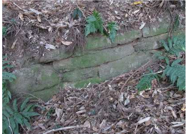
4段積列石 GH=88m 4段積みの列石を見る
