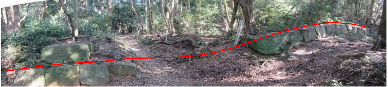
大社分岐 GH=123.0m 高良大社への分岐では列石が取り除かれ左側に積まれている 天端線に高低差が付いている
