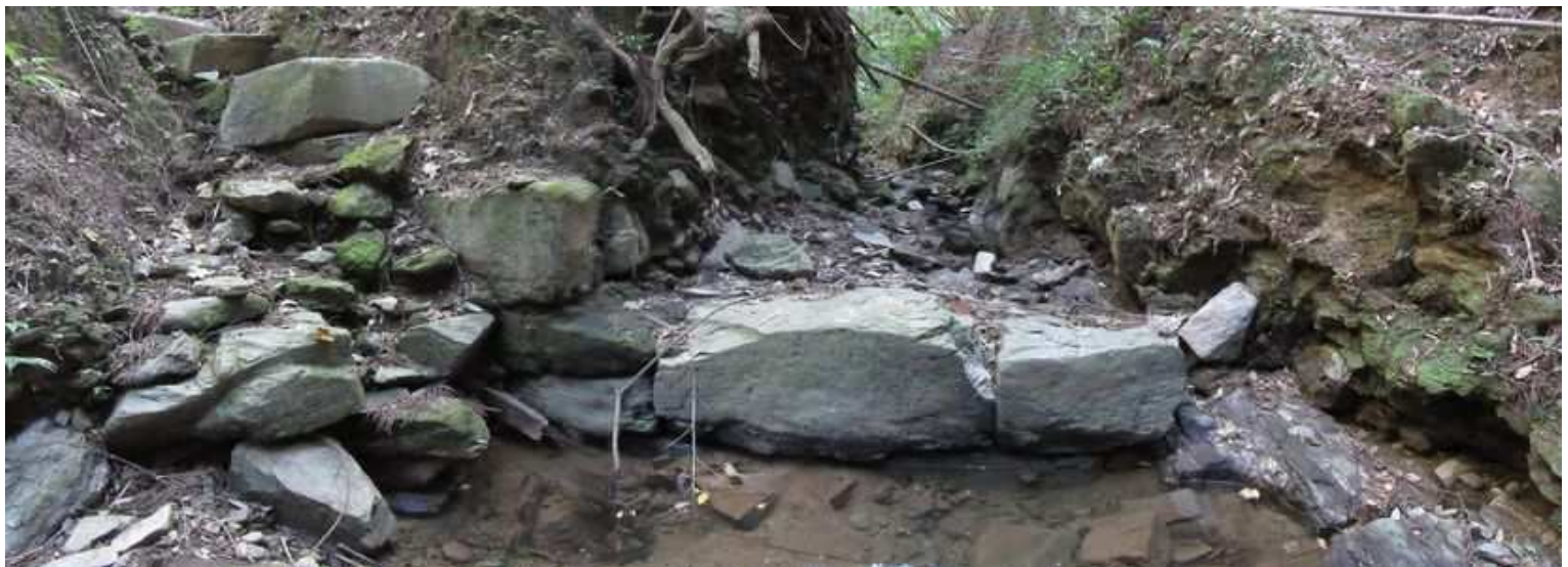
南谷水門 GH=74.3m 底石と右岸側階段状積石が残っている
