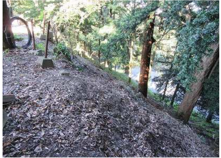
道路の北斜面は急な斜面となっている
