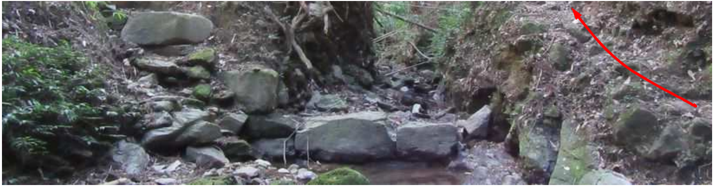
南谷水門 底石と右岸側階段状積石が残っている。左岸側の弱い踏み跡を辿る。
