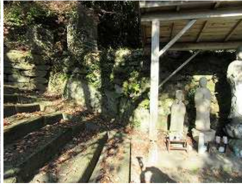
此处では列石の上に石垣が積んである。
