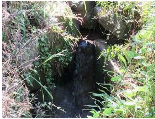
国道から右の脇道に入ると 第一水門 を見る。
