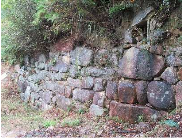
第2水門。水平目地を通る所もあり、布積みで基肄城南門跡の石積みに酷似しているようだ。
