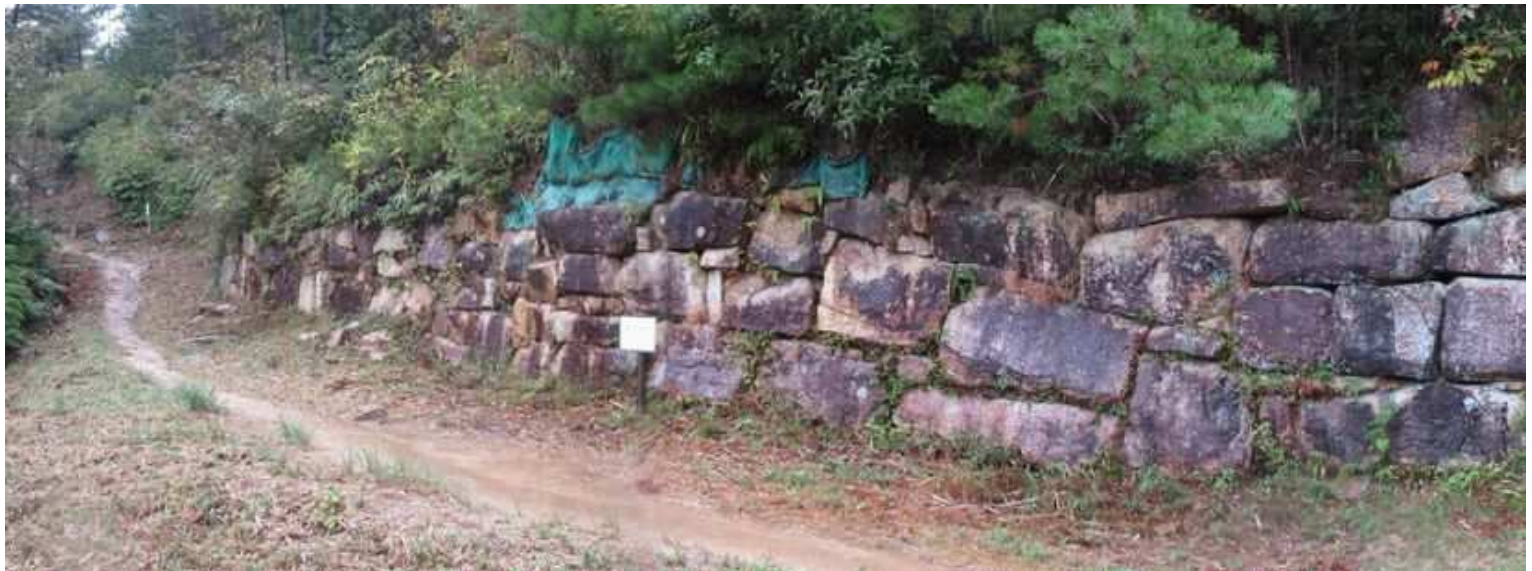
12:17 直ぐ先の第1水門は排水口を持たない。左側
