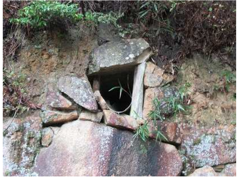
排水口が石積の上部に見られる。
