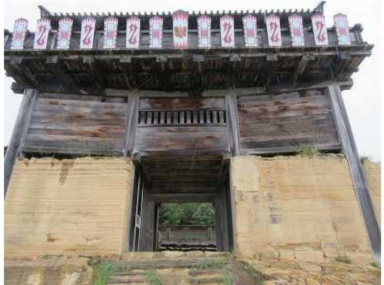
12:42 正面から西門を見る。
