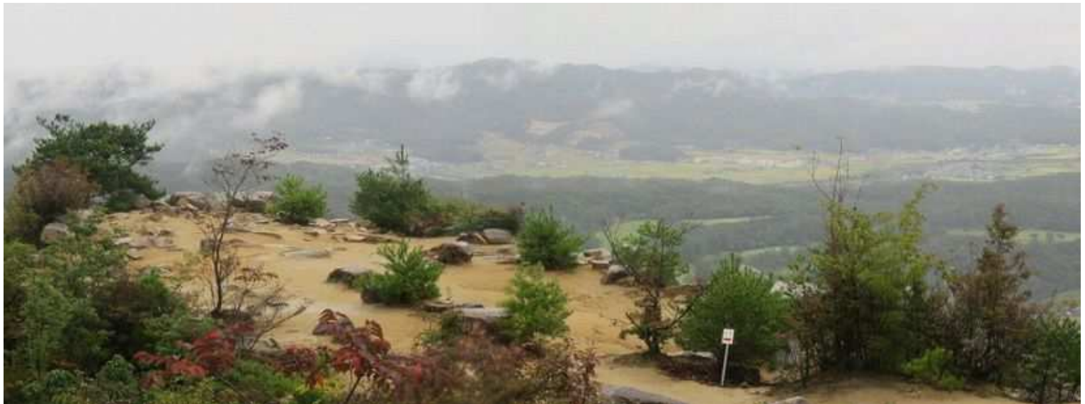
11:24 その先の高台から屏風折れの石垣を見る。
