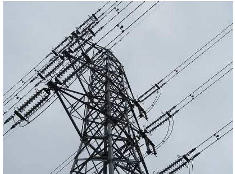
8:35 中国電力新倉敷岡山線34鉄塔を見上げる。
