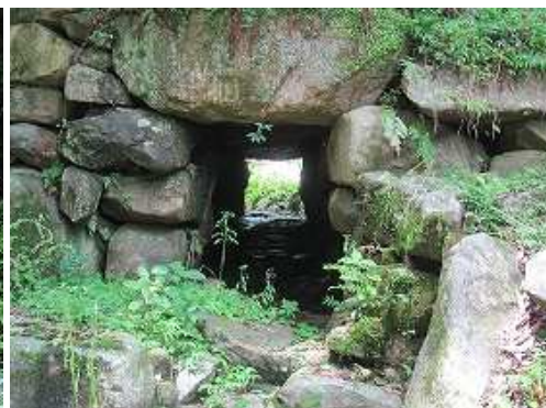
南水門跡の樋管に水は流れていない。
