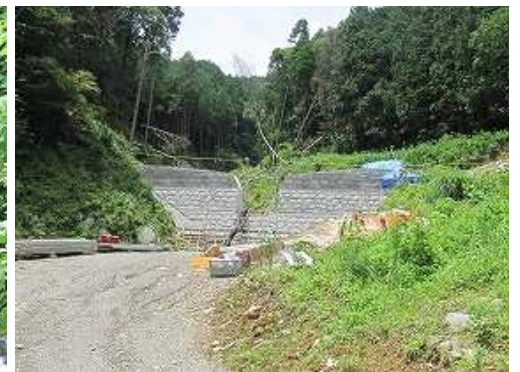
西側沢筋に 砂防ダム が完成つつある。
