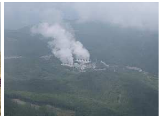
大岳地熱発電所を見下ろす。
