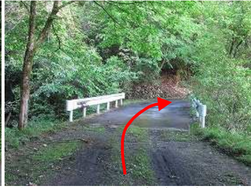
ガードレールのついた橋の手前が路肩が広いので此処に駐車し、歩き始める。
