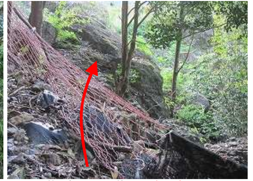
沢筋のネットたるみ箇所からネット内へ入る。
