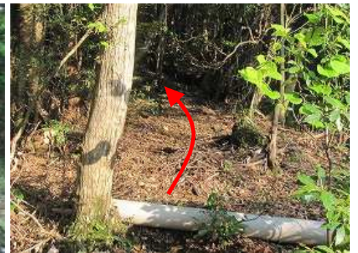
入口傍に塩ビパイプを見る。
