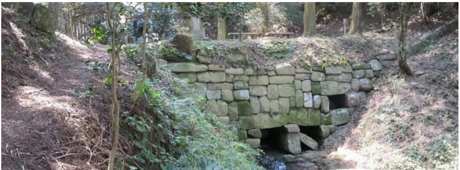
北水門。3つの排水溝が通されている。石材には鍵形に加工された石がある。
