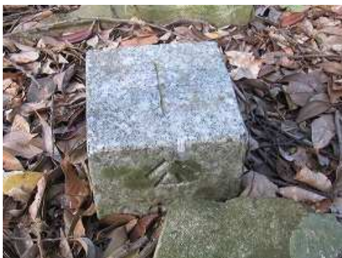
花崗岩製の公共杭が設置されている。
