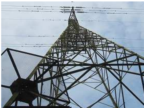
右に鉄塔2号を見上げる。
