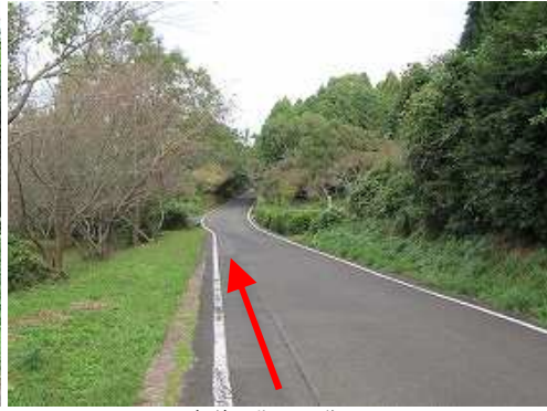
市道を北西に進む。
